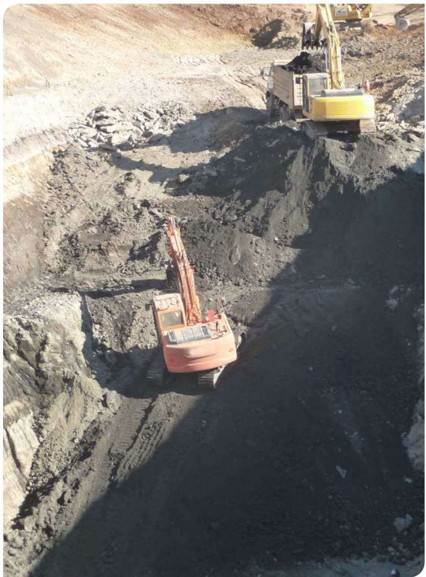
Excavación de Cámara de carga Central Itata.
