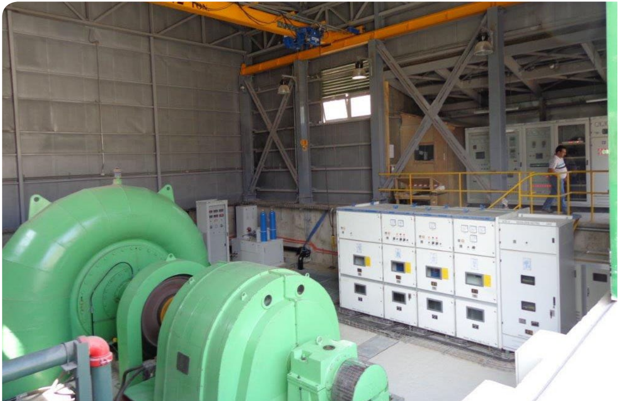
Central Las Vertientes, casa de máquinas.
