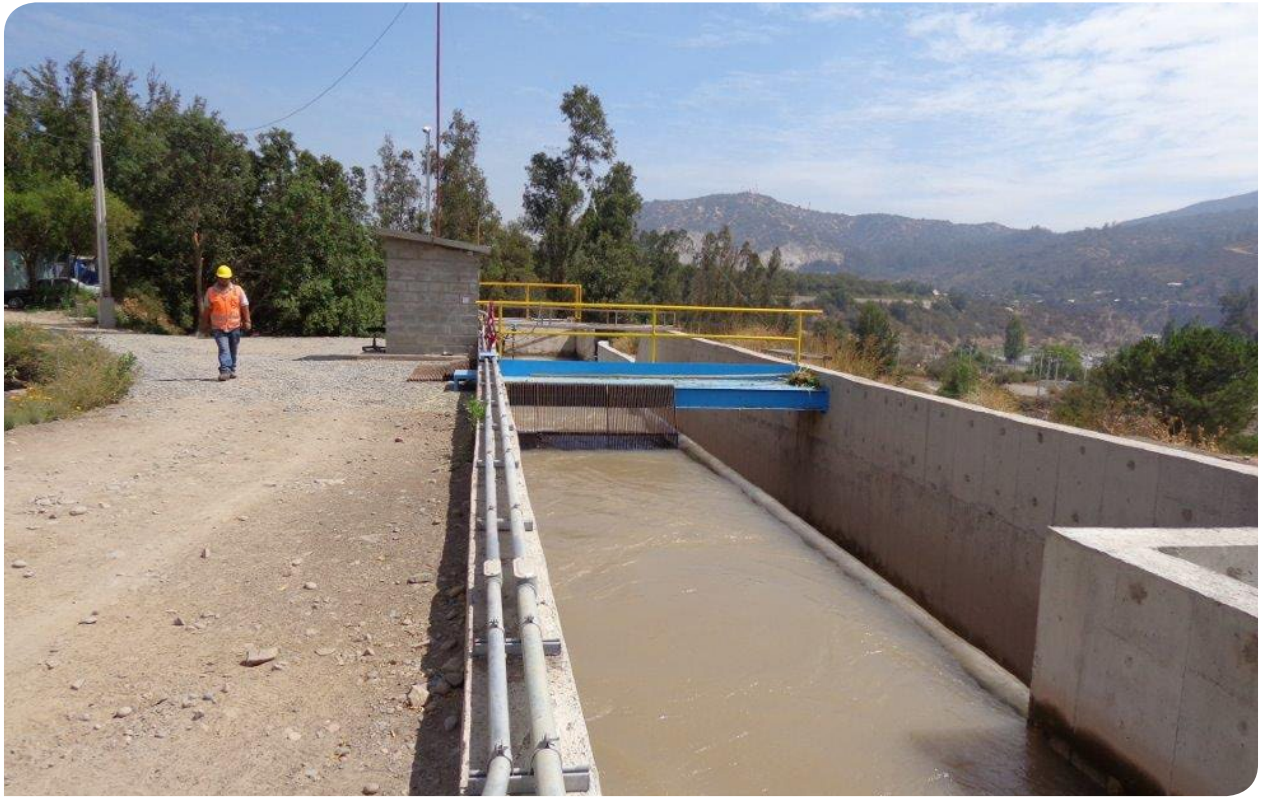
Cámara de carga Central Las Vertientes.
