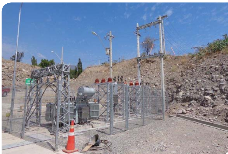
Central Las Vertientes, subestación de conexión al sistema de distribución de CGE.
