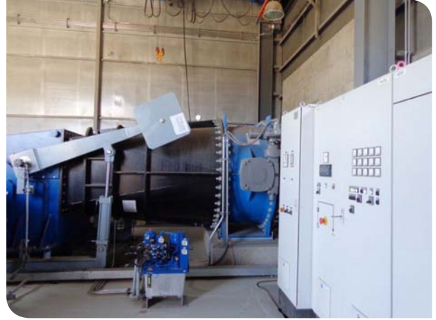
Interior Casa de Máquina Central El Llano.
