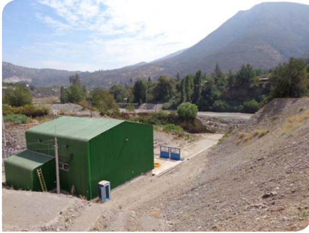
Casa de Máquina Central Las Vertientes (al fondo Río Maipo).
