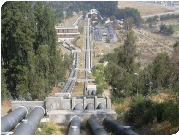
Izquierda Casa de Máquina Florida 2 y al centro Casa de Máquina Florida 1.
