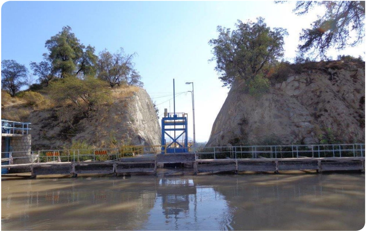
Compuerta de Aducción a cámara de carga Central El Llano.
