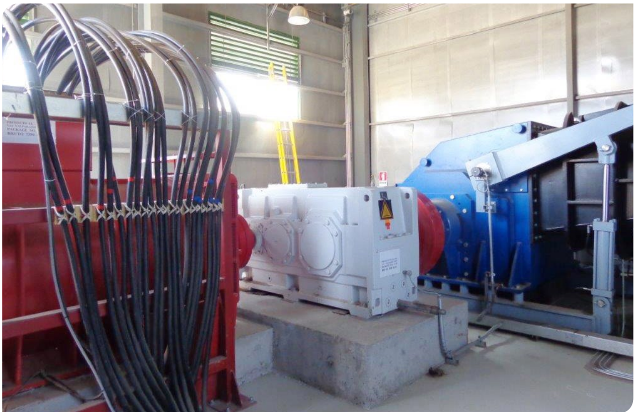
Central El Llano, casa de máquinas.
