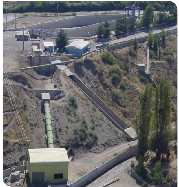
Desarenador, tubería de Aducción, Casa de Máquina Central Eyzaguirre.
