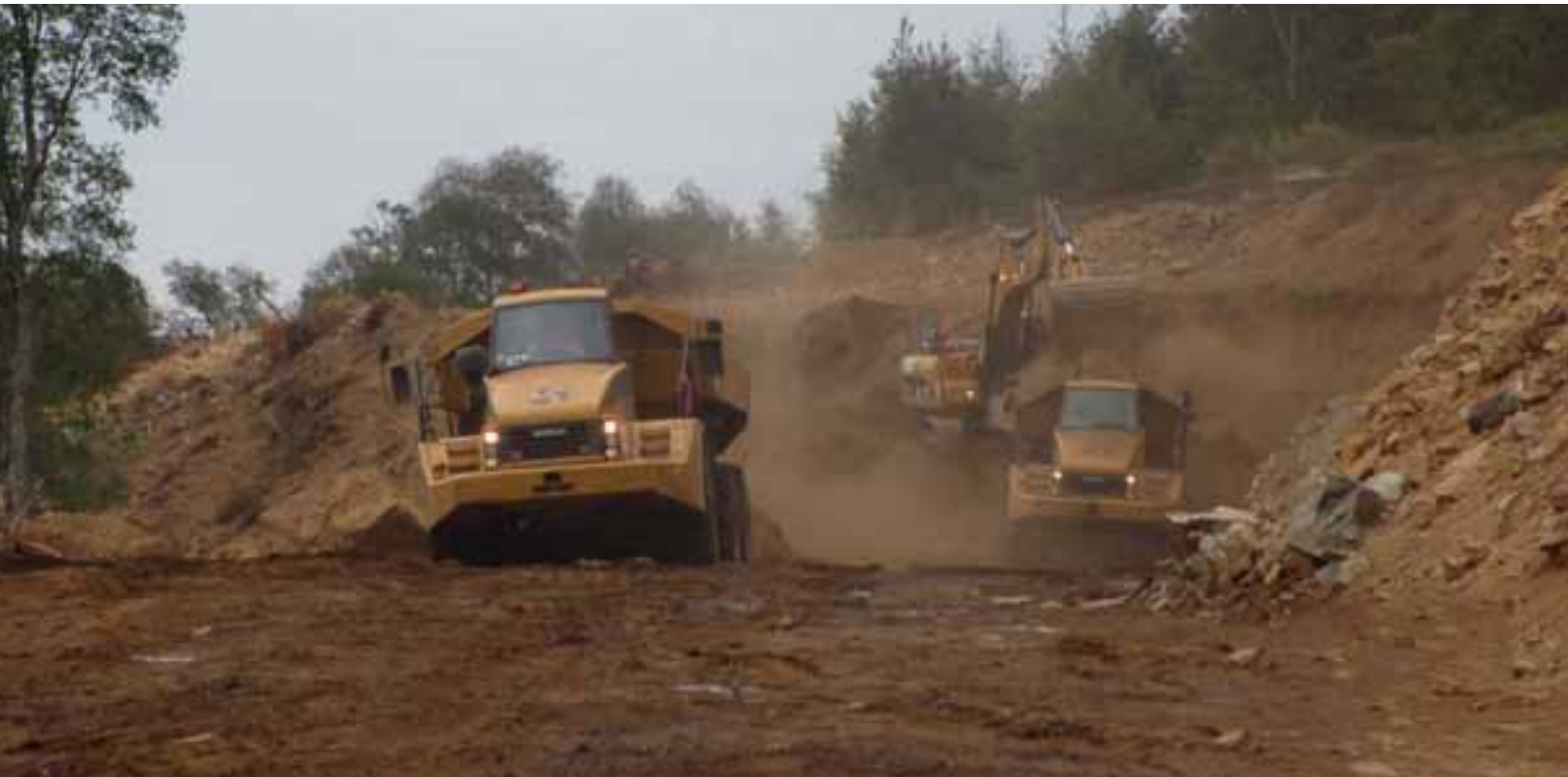
Proyecto Ñuble: Excavación faena construcción Km. 13,140-13,160 (Canal de aducción).
