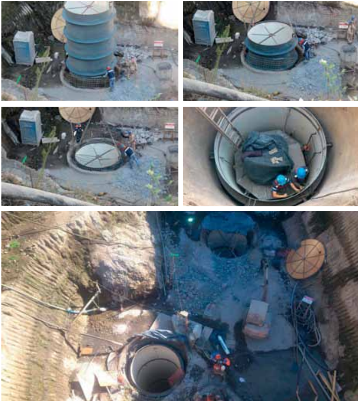
Itata: Pique en Presión N° 1 y 2: Se aprecia en boca de ambos piques el primer segmento de curva vértice V1.
