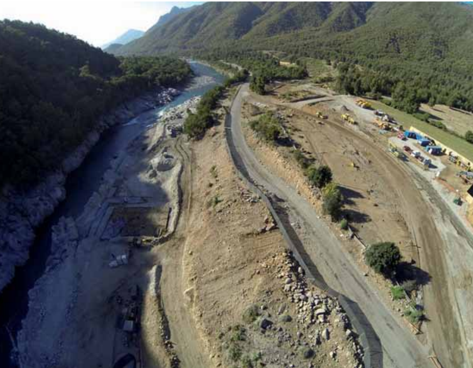
Proyecto Ñuble: instalación de faena del contratista de obras civiles en sector Bocatoma.
