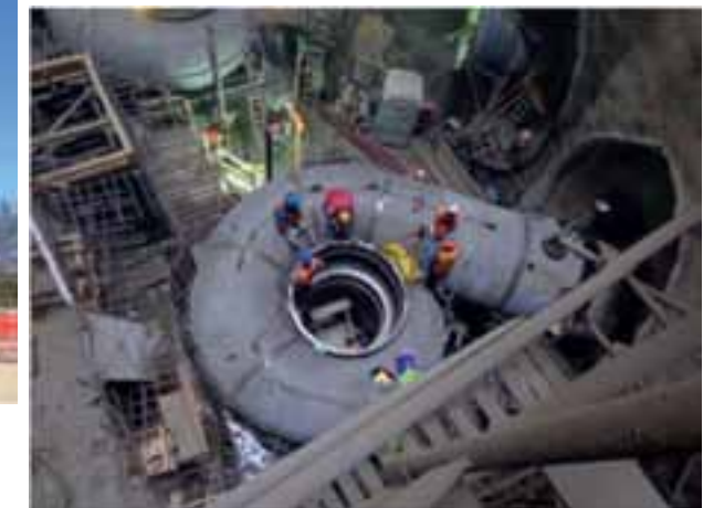
Instalación de caracol para turbinas Mini central Itata.
