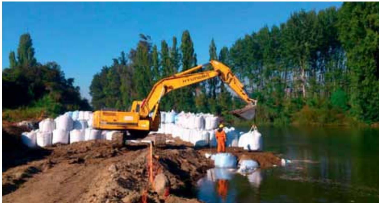
Itata: Vista general de colocación maxisacos para protección en la construcción de obras de captación.
