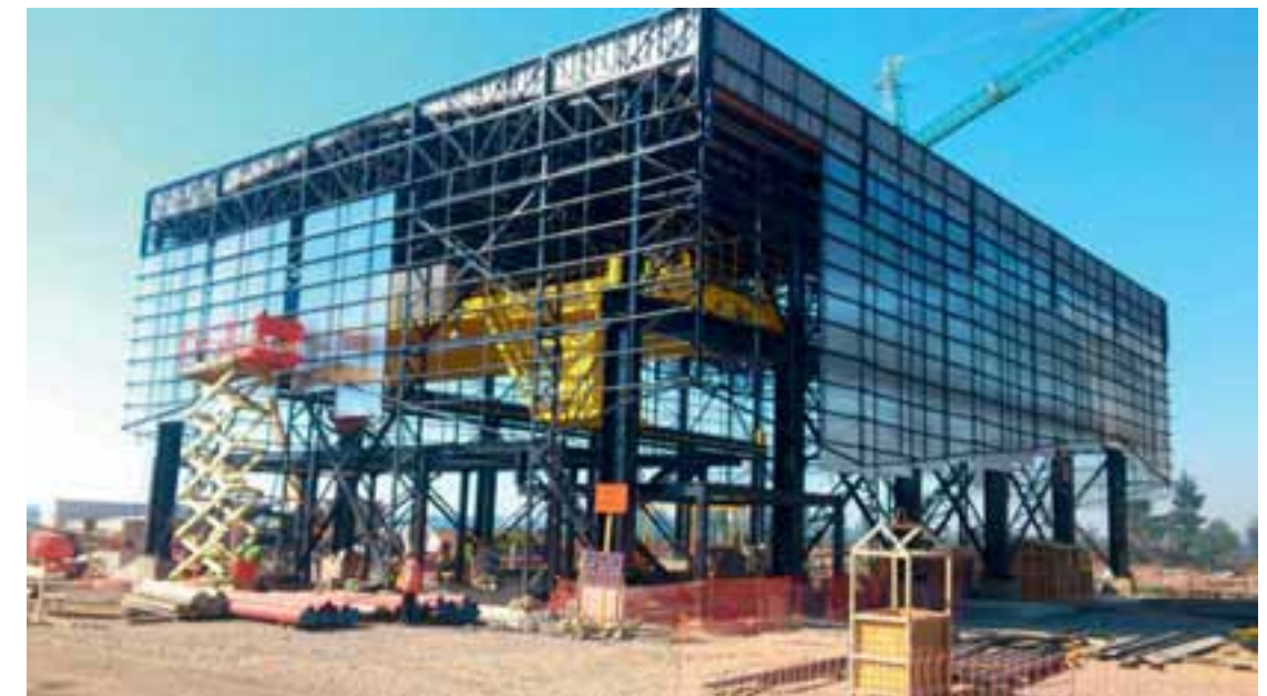
Itata: Superestructura casa de Máquinas (revestimiento interior).
