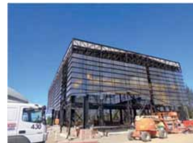
Itata: Construcción Casa de Máquinas de la Mini central Hidroeléctrica Itata.
