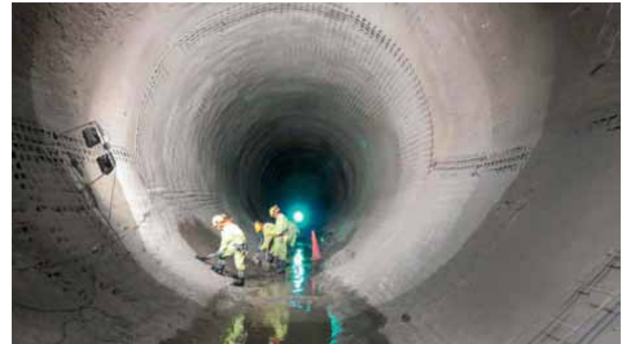
Túnel devolución: Limpieza tramo de túnel blindado para colocación shotcrete de revestimiento.
