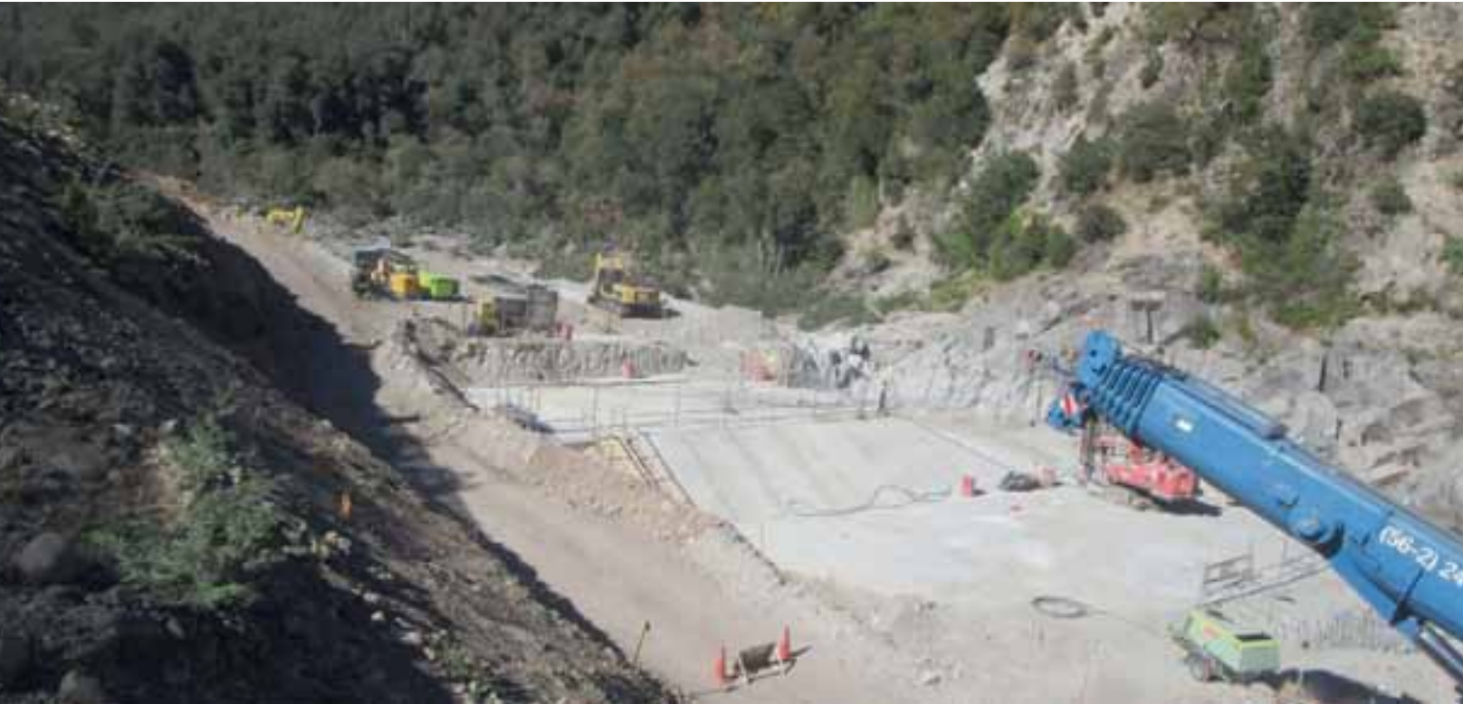
Proyecto Ñuble sector Bocatoma: Vanos 2 y 3 (emplantillado) sellos de excavaciones para ejecución de inyecciones.
