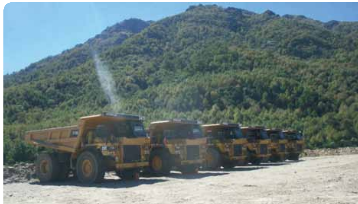
Proyecto Nuble: Camiones para movimiento de tierra casa de máquinas y Canal de devolución.
