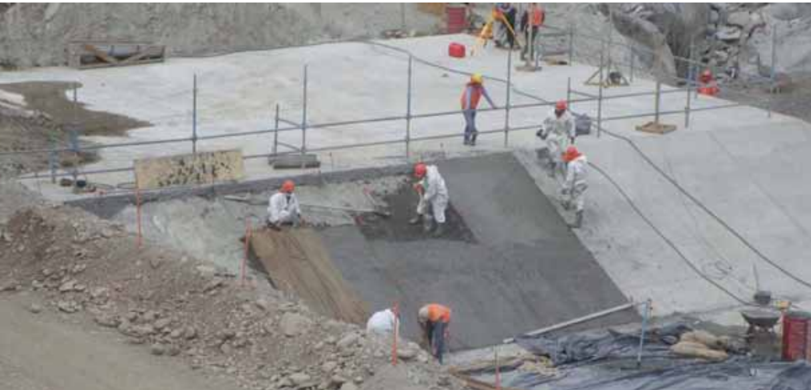
Proyecto Ñuble sector Bocatoma: Vanos 2 y 3 (emplantillado) sellos de excavaciones para ejecución de inyecciones.
