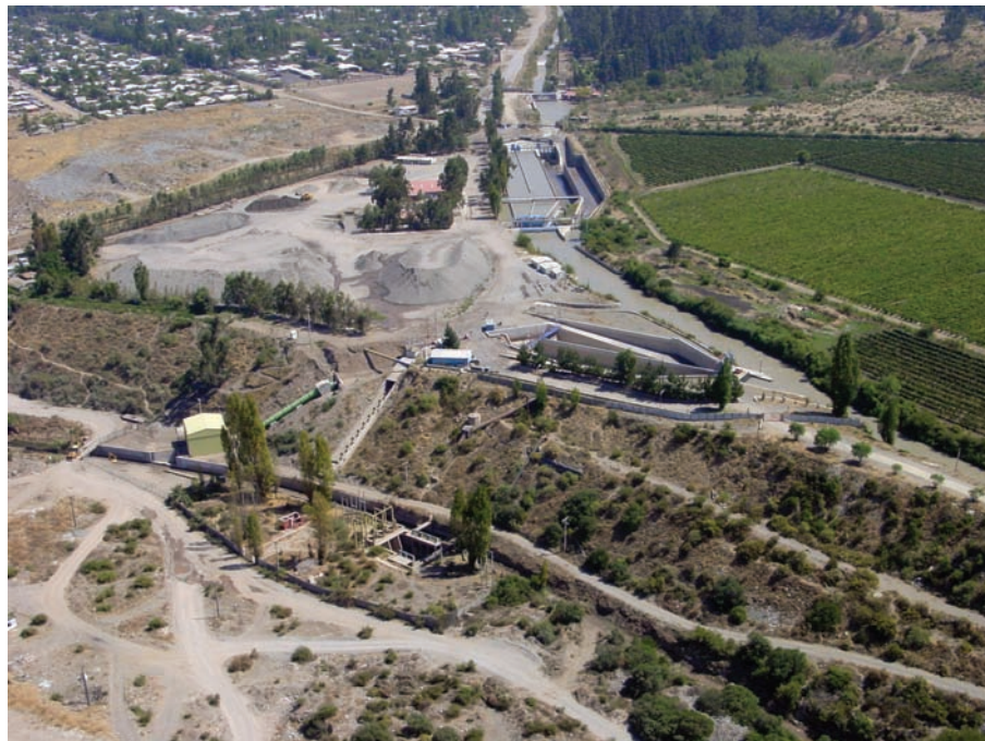
Desarenador de la Central Florida e instalaciones de la Central Eyzaguirre
