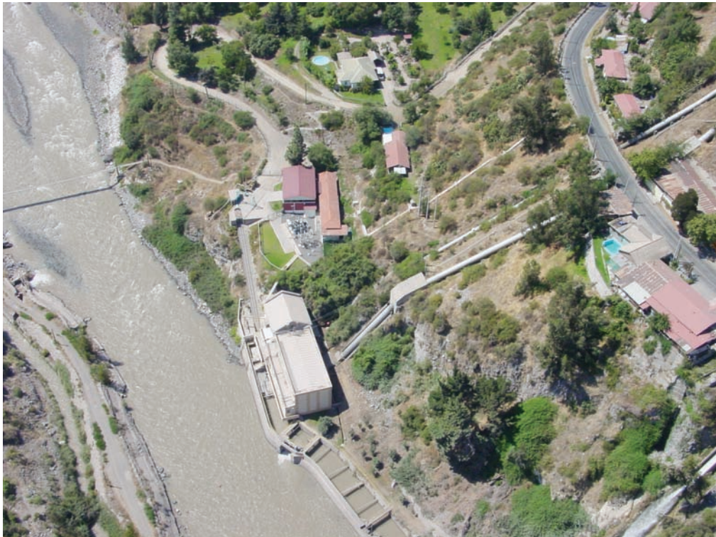
Tuberías de presión y casa de máquinas
