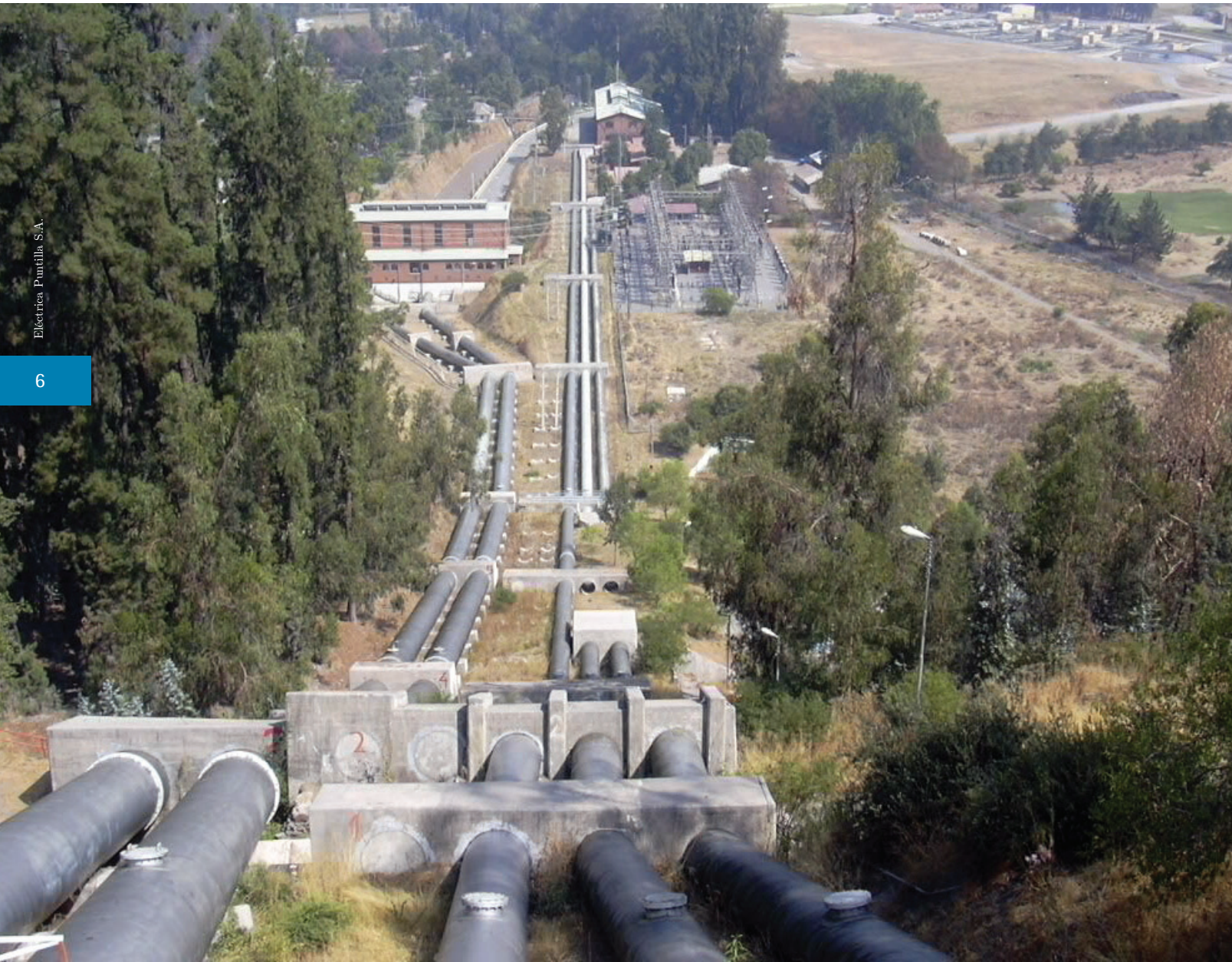
Vista general del Complejo Florida desde la cámara de carga
