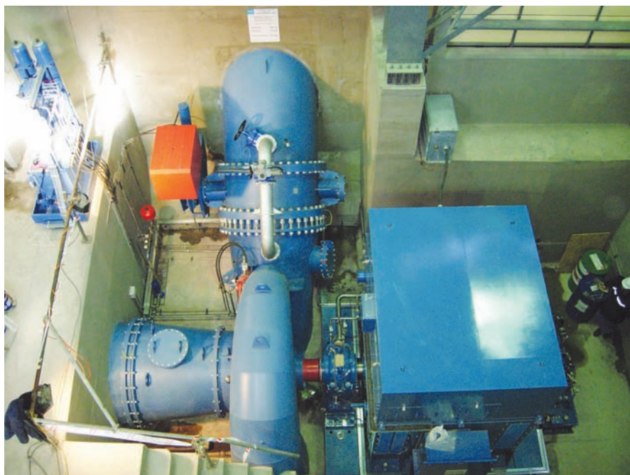
Vista de unidad 3 desde el puente grúa de sala máquinas
