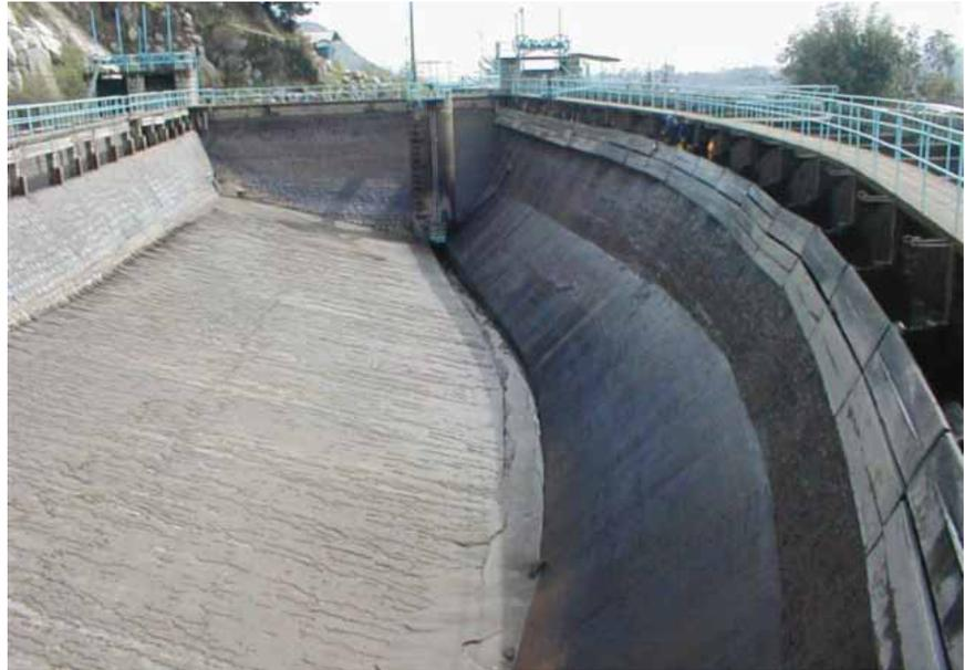
Desarenador de la cámara de carga de Central Puntilla
